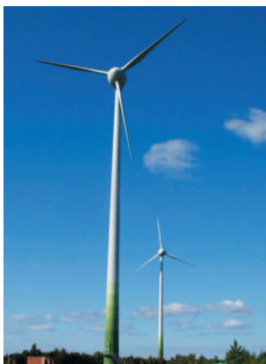
Virtsu tuulepark, koguvõimsusega 1800 kW (3x600 kW)
